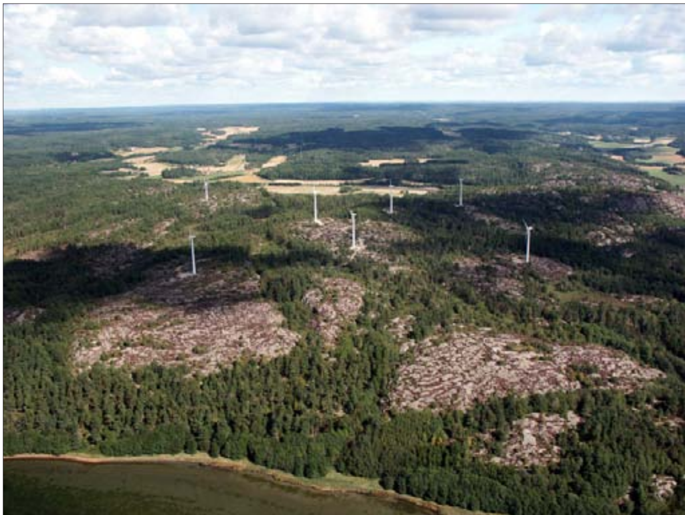
Nedan: Anläggningen vid Sannäs. - I det bohuslänska landskapet finns många vegetationsfattiga bergsplatåer där fundament enligt "Rock adapter"-metoden ger minimala skador. Byggande av tillfartsvägar kan däremot ge skador på naturmiljön.
