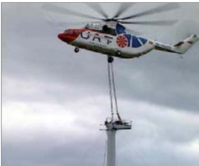
Helikoptermontering av maskinhus i Jämtlandsfjällen (foto Bohus Energi AB).
